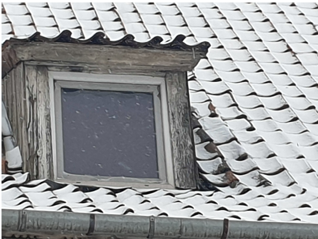
Foto 7 Obecne pokrycie dachu z dachówki typu S. Widoczna lukarna na połaci frontowej
