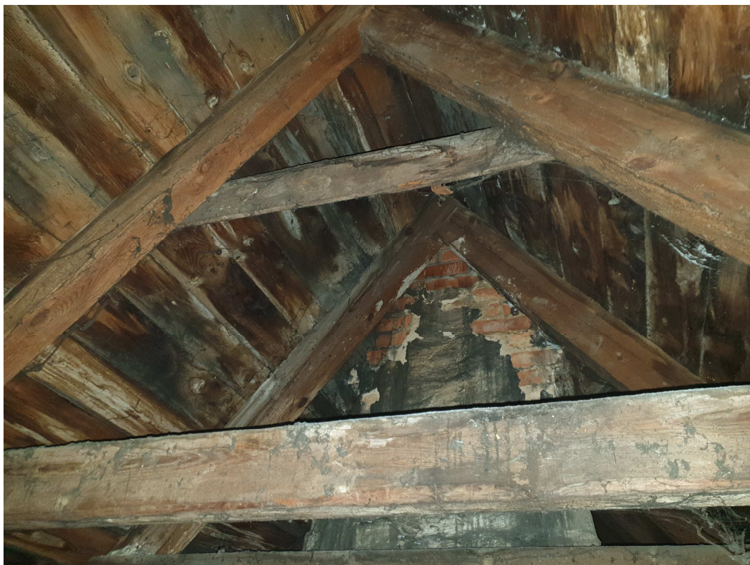
Foto 6 Ślady zagrzybienia deskowania przy kominie spowodowane nieszczelnością pokrycia dachowego i zaciekaniem wód opadowych.
